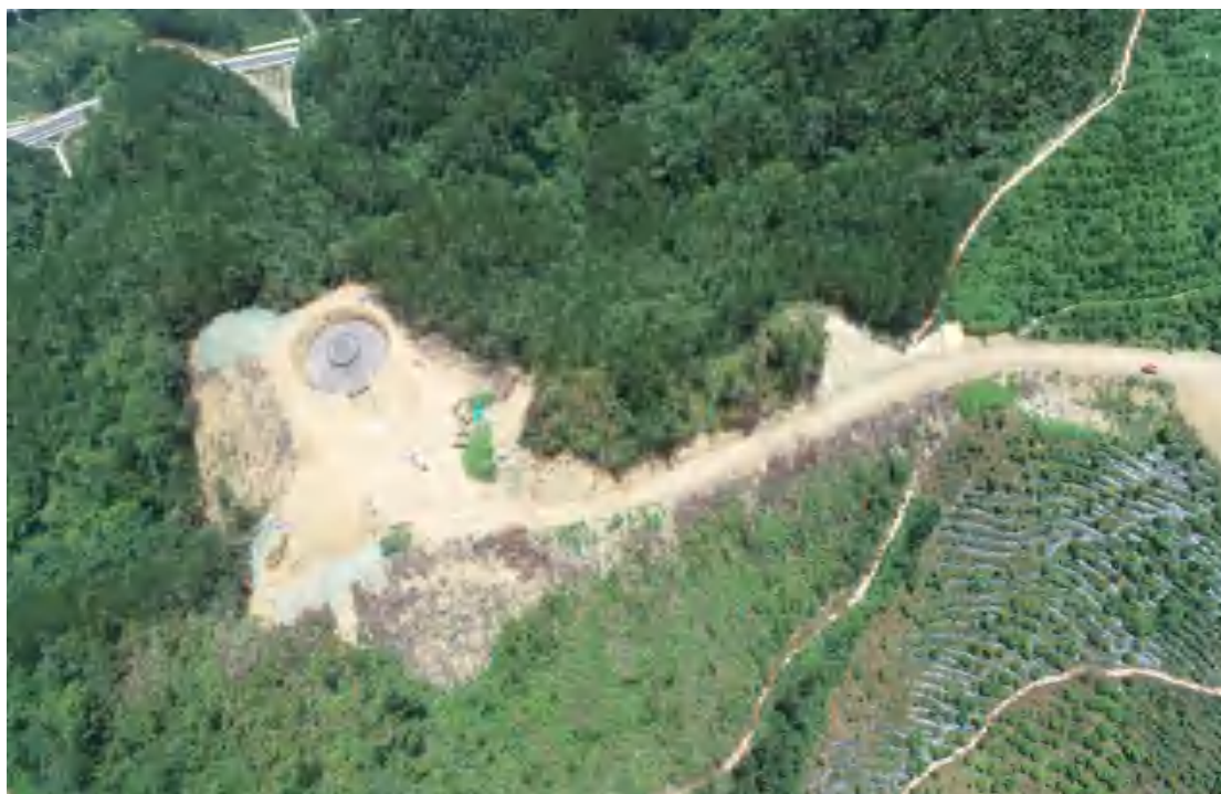
监测过程 1#风机实施的临时防护（2023.06.28）
