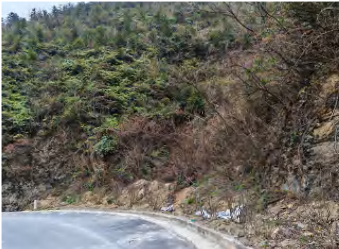
监测过程中集电线路植被建设情况 (2024.04.01)
