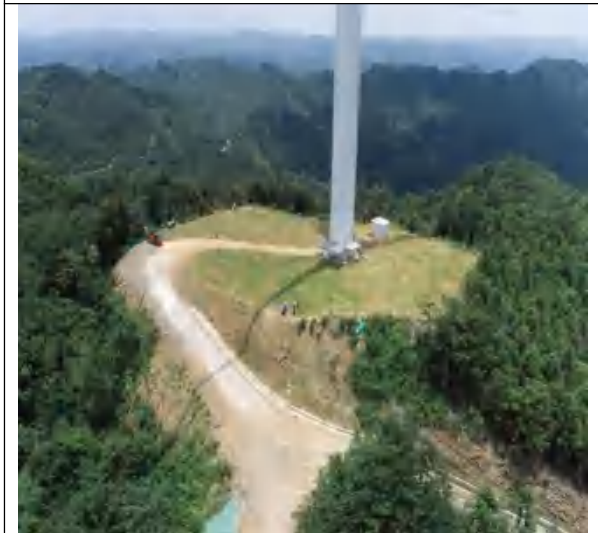
XT25 风机平台植被恢复和排水沟
