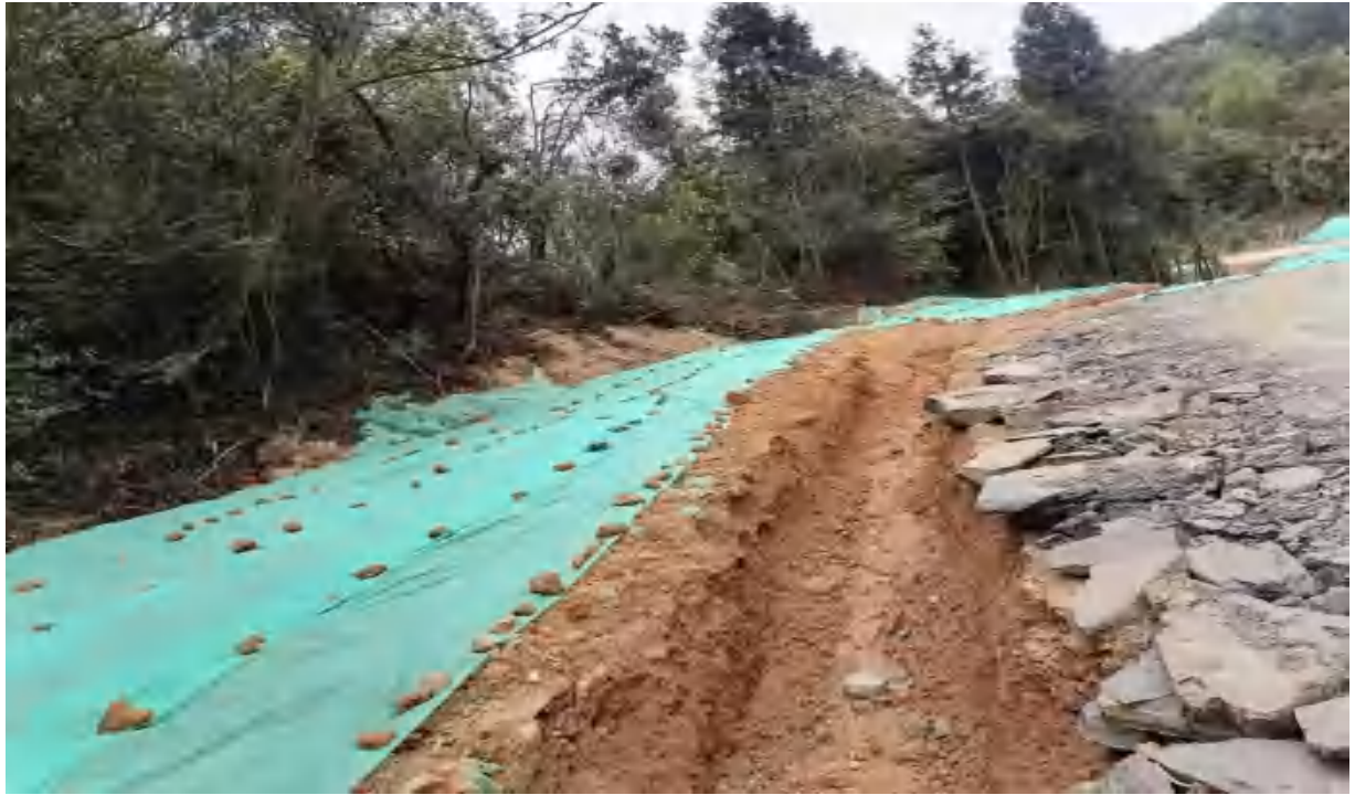
监测过程中实施的临时排水沟和临时苫盖（2023.06.28）
