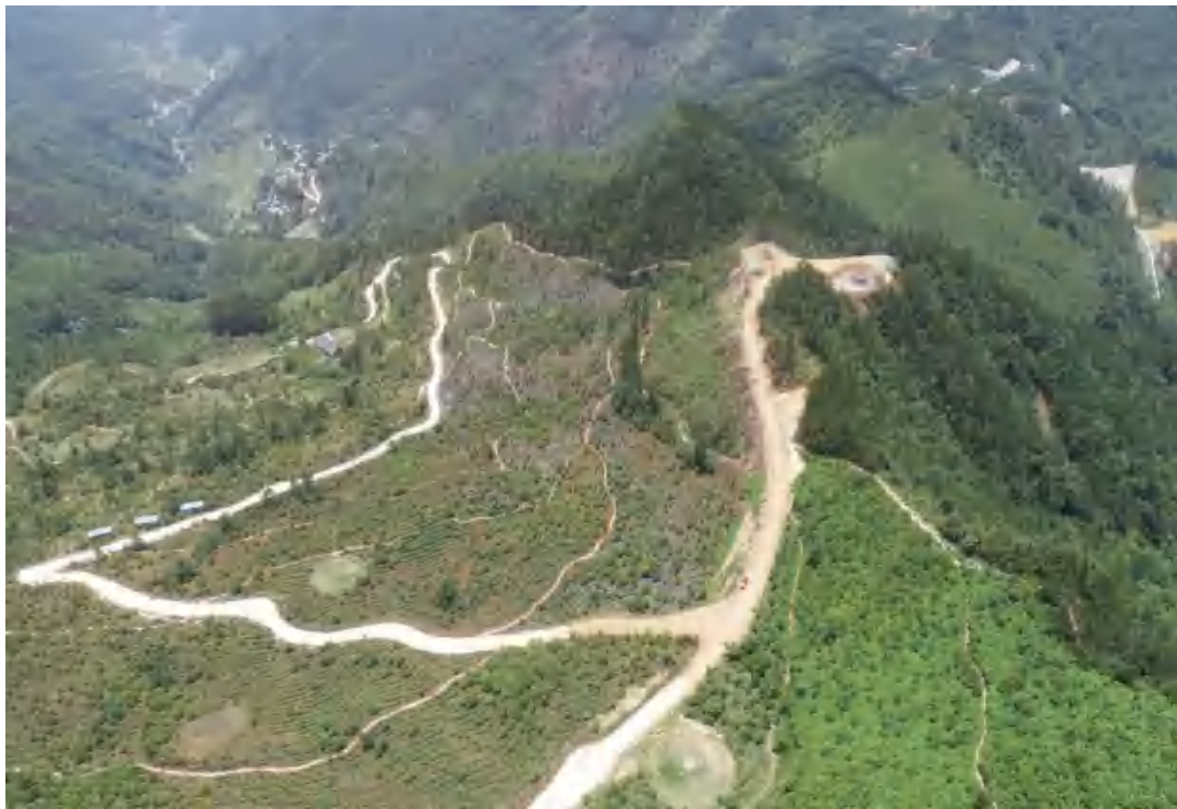
监测过程项目区 1#风机实施的边坡临时防护和覆土整治工作（2023.06.28）
