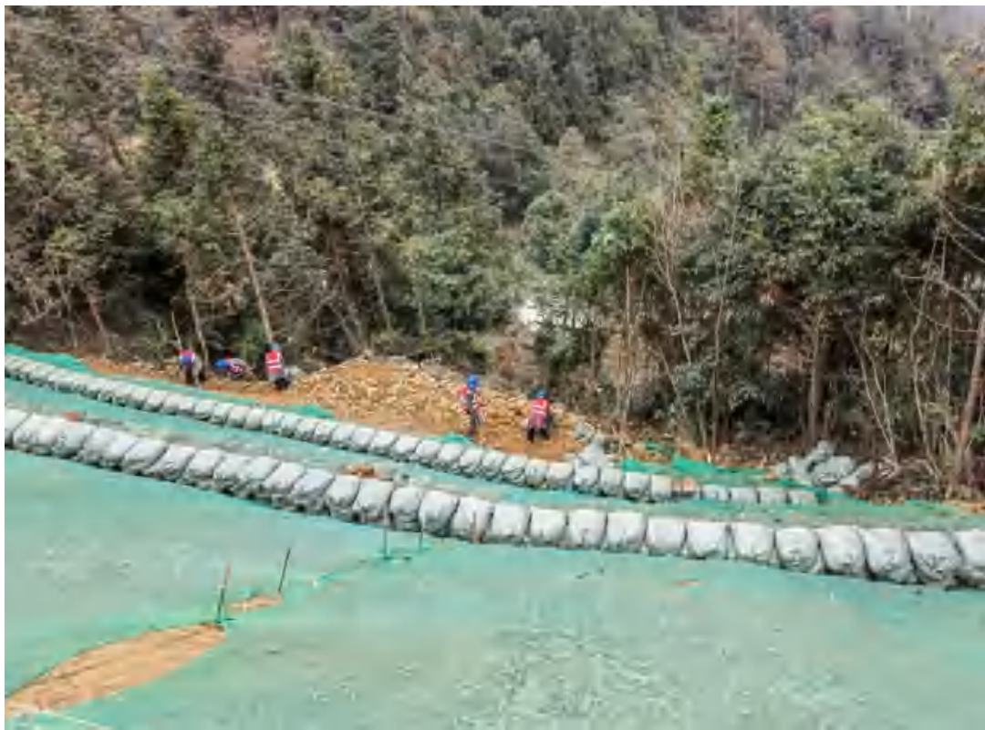
监测过程中实施的临时拦挡（2023.06.28）
