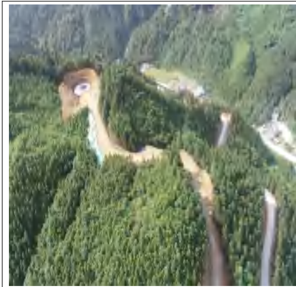
10号风机基础开挖和临时苫盖情况
