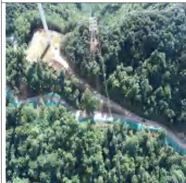
XT11 风机平台植被恢复和上边坡喷薄植草
