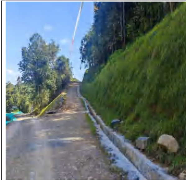
X105 风机进场道路喷薄植草和排水沟
