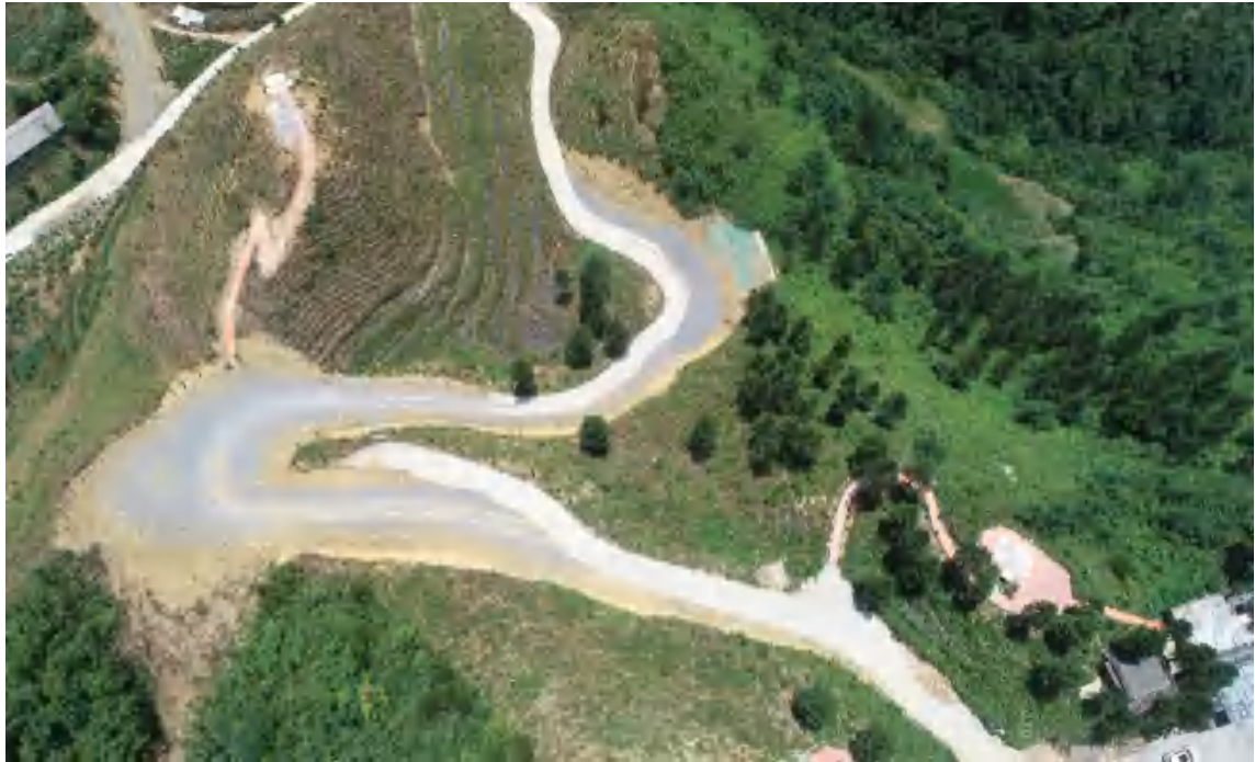
监测过程 1#风机道路填方区实施的临时防护和挡土墙（2023.06.28）
