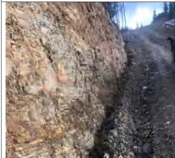
道路临时排水沟
