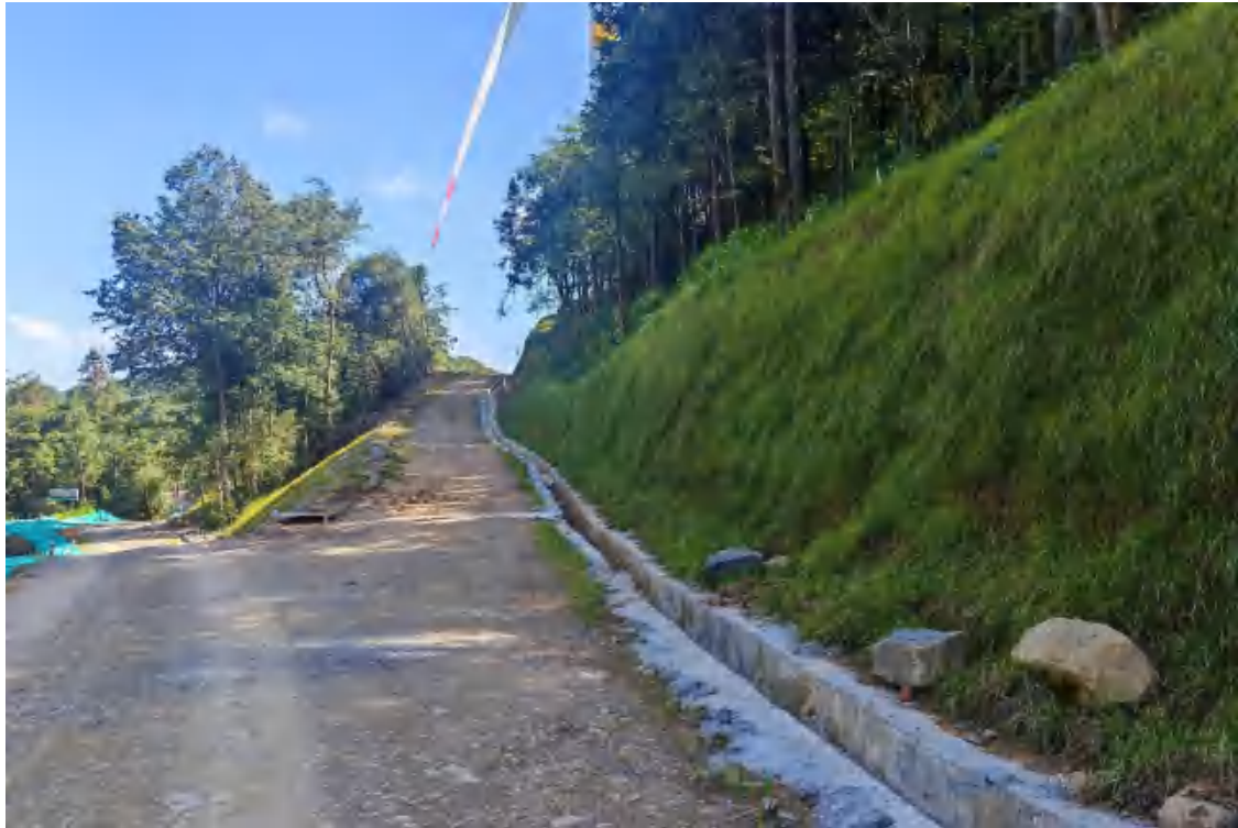
监测过程中喷薄植草和排水沟（2024.07.05）
