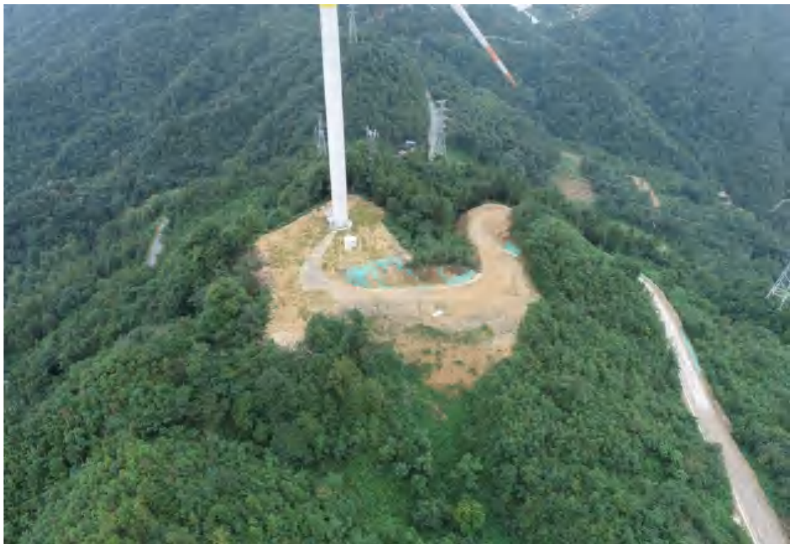
监测过程中临时苫盖和植被恢复情况（2024.07.05）
