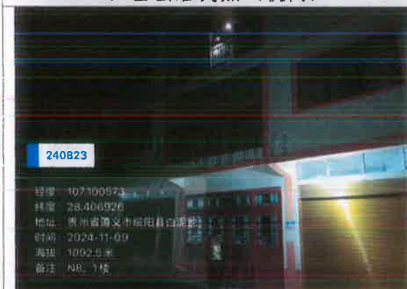
N8 铜锣井村居民点 1 楼 (夜间)
